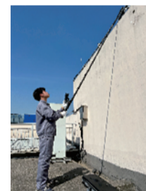
inspección de tejados
