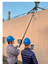
inspección de la construcción (transmisión de imágenes WIFI en tiempo real)
